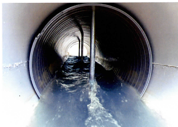
写真4 支保工簡易化の状況
