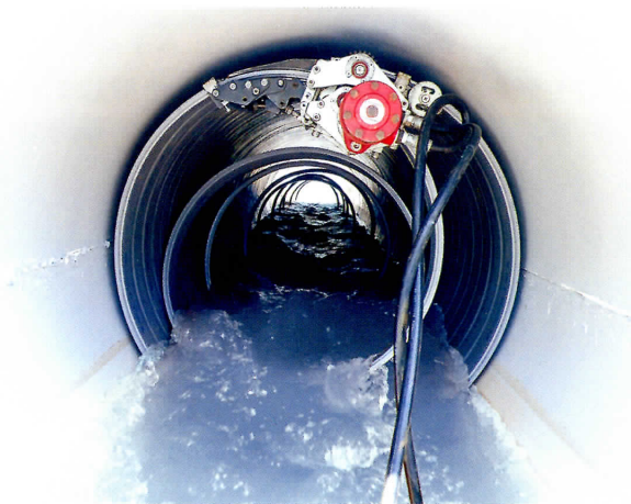
写真1 製管時の流下状況
